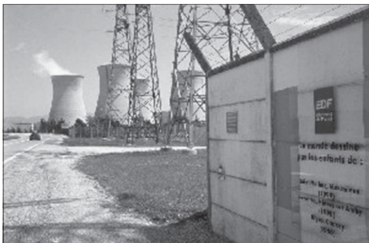
La centrale nucléaire du Bugey est à une centaine de km de Genève
