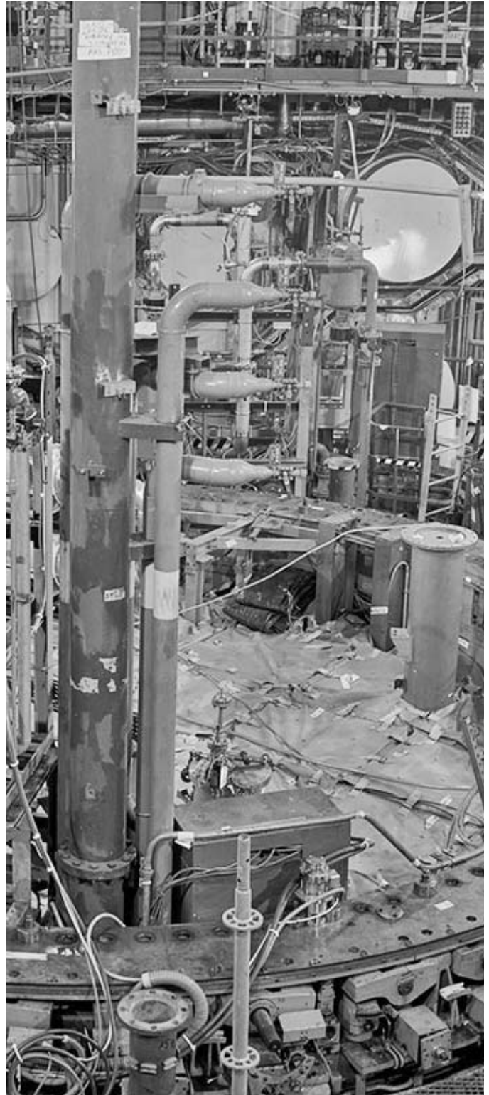
La cuve du réacteur de SPX en déconstruction.
