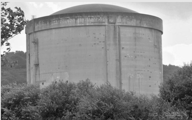
Photo: Bâtiment réacteur de la centrale nucléaire de Brennilis
